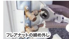
フレアナットの締め外し
